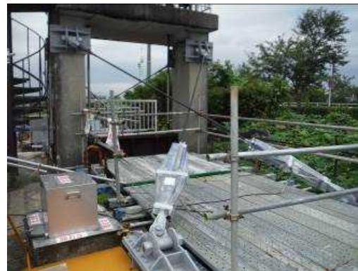
図-4 ケーブル緊張後の状態
